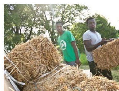
Aufschichten der Strohballen im Mauerverband – in Reihen quer zur Brücke.
