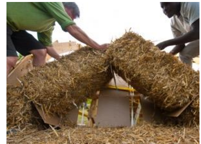
Kompression der Ballen in der Einklapptechnik ab der 5. Reihe (quer zur Brückenrichtung).
