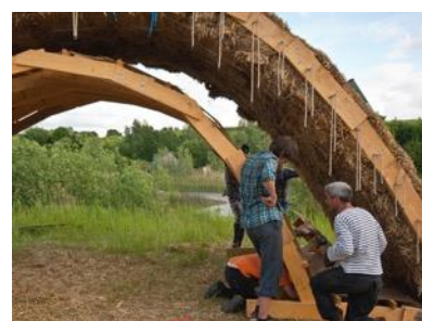
Abbau der Schalung
