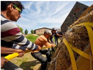
Komprimieren der Ballen mit Lkw-Gurten in den ersten 4 Reihen (einschließlich Randbohlen)
