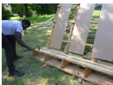
Bau der Auflage für die Strohballen und Verankerung im Erdreich (Fußpunkt)
