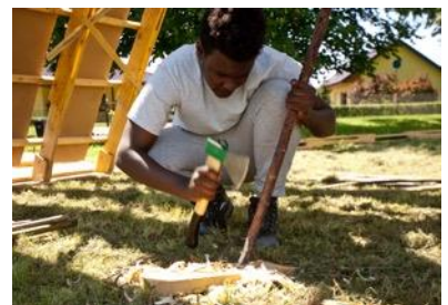
Weidenstöcke werden angespitzt, um sie als Pins (Nadeln) zur Verbindung von Ballen zu verwenden.
