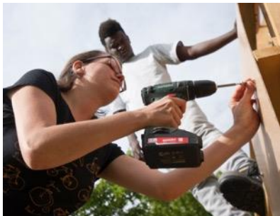
Montage der Dachlatten und Hartfaserplatten
