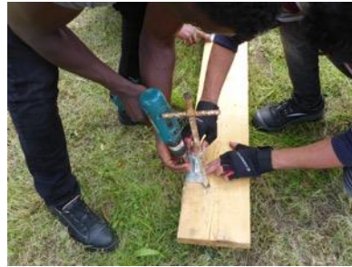
Setzen der Schwelle für die Schalungsbögen und Verankerung im Boden mittels
