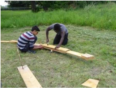
Montage der Schalungsbögen aus vorgefertigten Elementen
