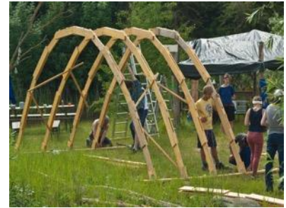
Aufrichten der Schalungsbögen und Positionierung mit Hilfe von Streben
