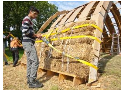
Abnahme der Lkw-Gurte nach dem Komprimieren der Strohballen
