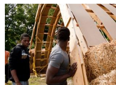
Aufstellen der Randbohlen nach Verlegen von 4 Reihen mit Strohballen auf jeder Seite
