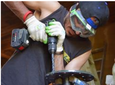
Vorbereitung des Anschlusses am Wasserspeicher
