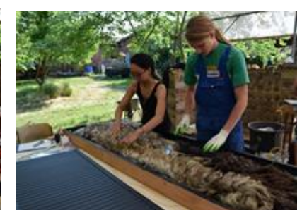
Einlegen der Schafswolle als Wärmedämmschicht
