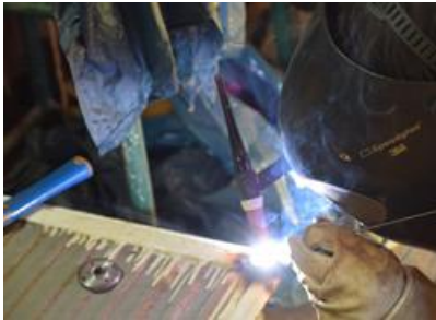
Anschweißen eines Anschlusses: alte Heizkörper werden zu Absorbern
