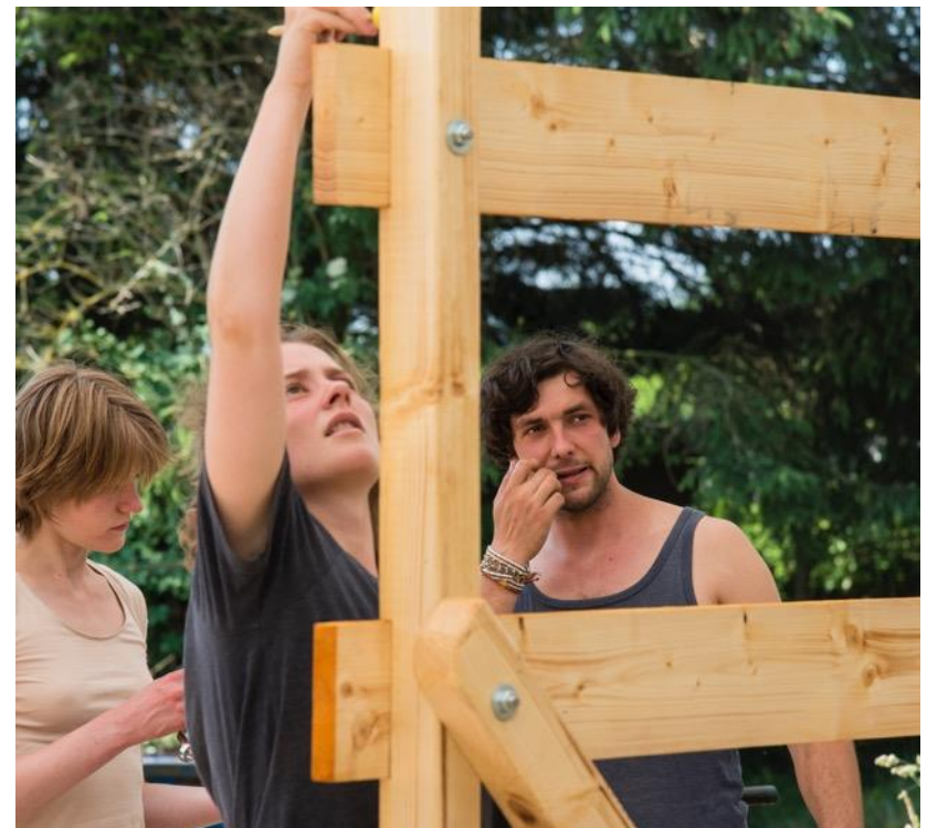
Bau des Gerüsts für den Kollektor und Speicher
