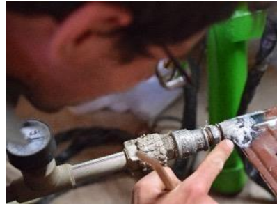
Prüfen der Schweißnaht auf Luftdichtigkeit mittels zugeführter Druckluft und Seifenwasser
