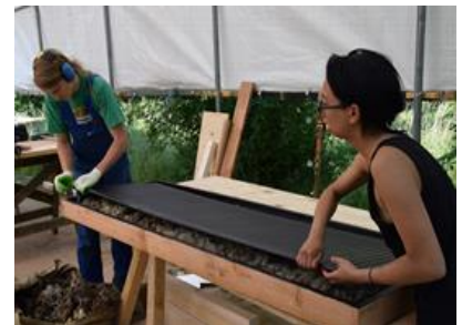
Einlegen des schwarz gestrichenen Heizkörpers in den Kollektorkasten
