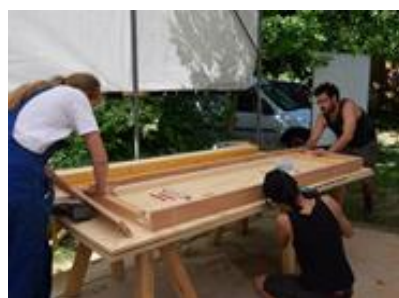
Bau des Kollektorkastens
