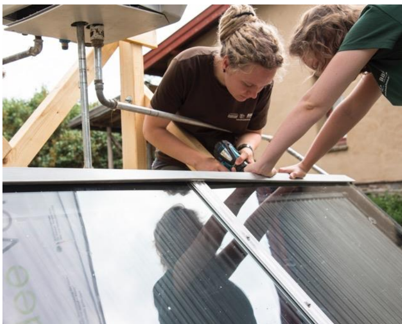
Endmontage: Anschrauben der Abdeckbleche
