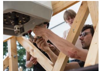
Endmontage: Anbau der Duscharmatur
