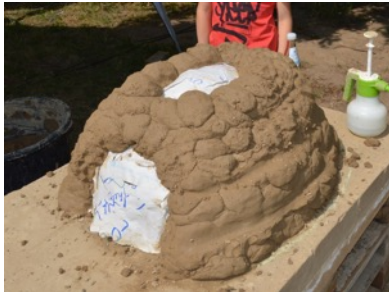
Aufsetzen der Lehmbröte
