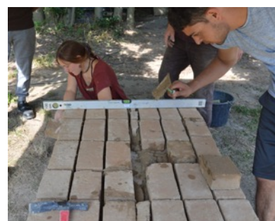
Mauern der Grundplatte
