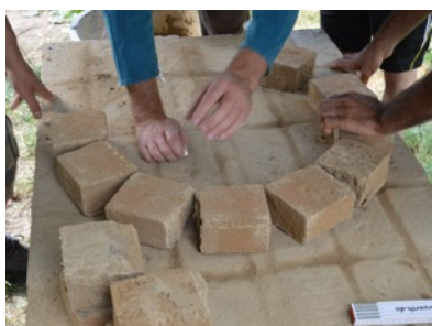
Auslegen des Grundrisses des Tandoor-Ofens mit halben Steinen
