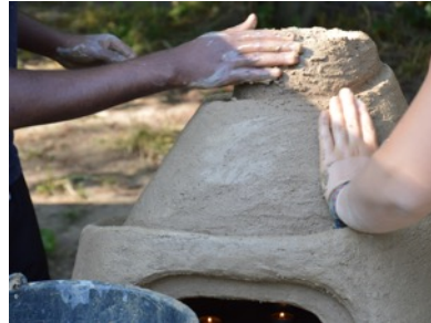
Verputzen und Gestalten
